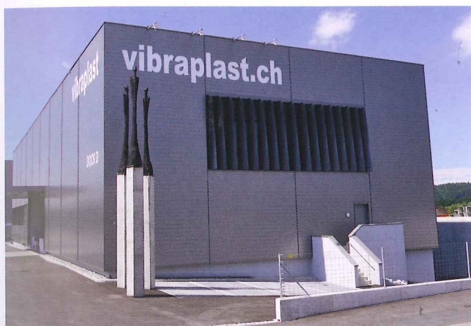
Die Vibraplast AG hat heuer das Dock D, einen zweigeschossigen und 12 m hohen Bau, in Betrieb genommen.
